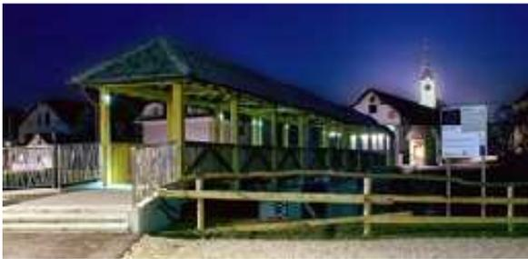
La passerella per pedoni è coperta e costruita su colonne in cemento, dotata di recinzione e pavimento in legno, mentre il tetto è a falde classiche. Sull'argine destro, in prossimità della cappella, l'accesso alla passerella si allarga e conduce ad un punto di ritrovo e di birdwatching. In questo modo il ponte acquisisce un valore simbolico di collegamento della parte vecchia di Gorenja vas con la parte nuova che termina proprio nella nuova piazza.
