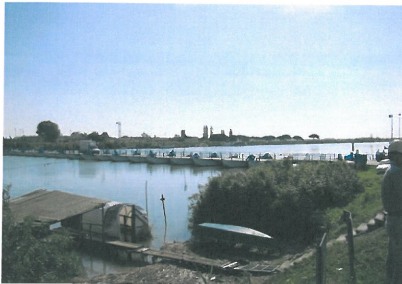
Pontonski most pri Santa Giulii, foto: Ekomagazin.si
